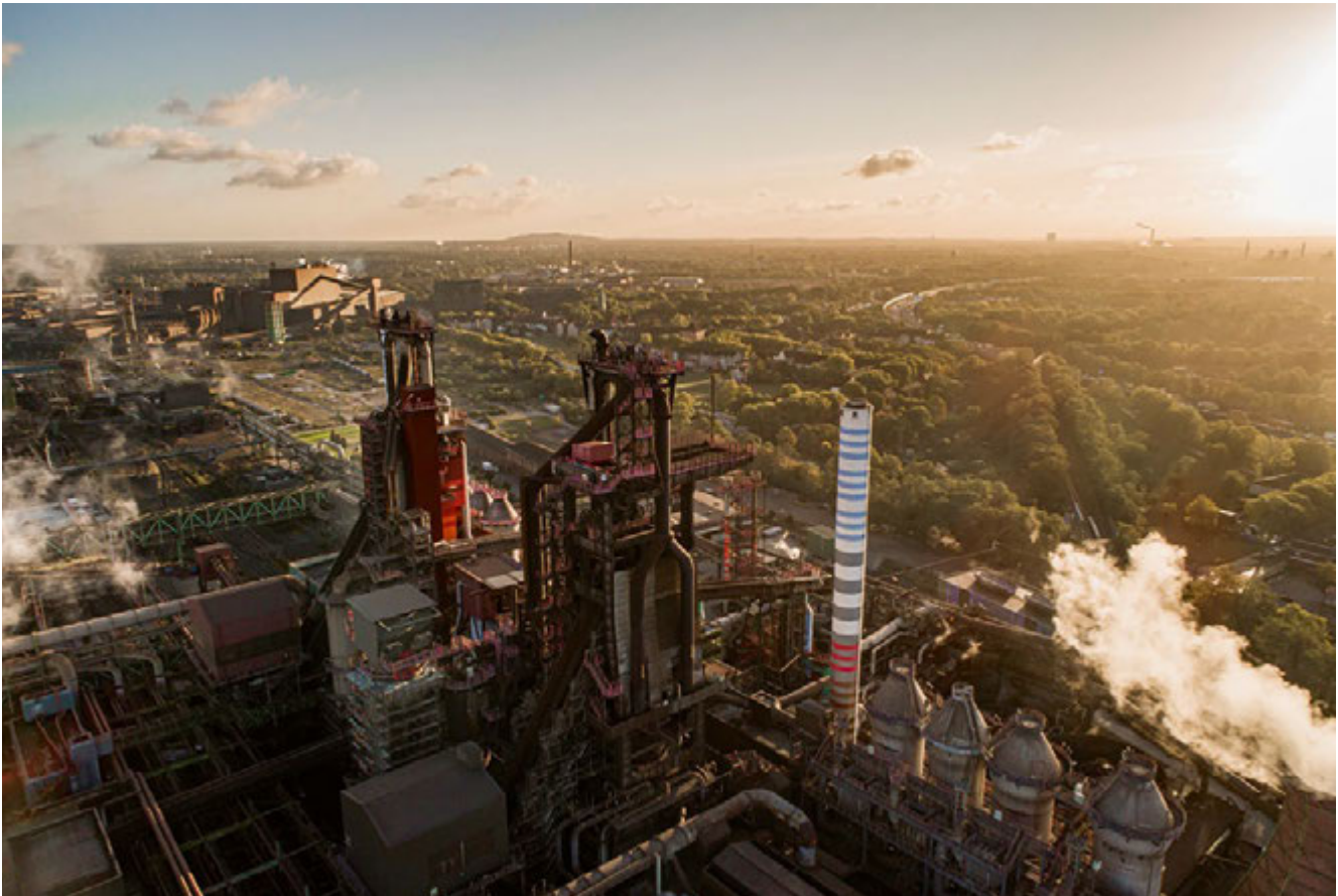
► Abb. 1 / Hochöfen 8 und 9 von thyssenkrupp Steel in Duisburg.
