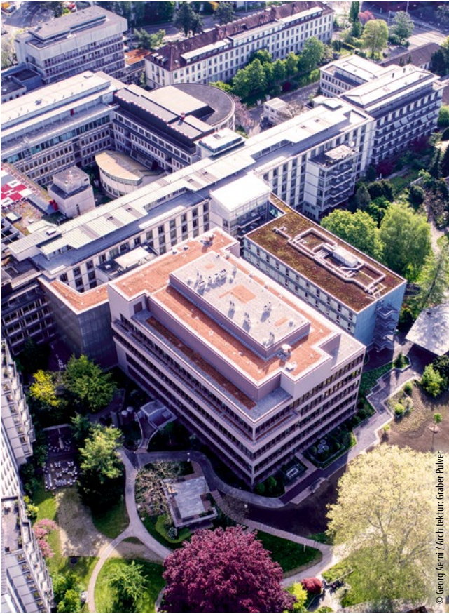
► Abb. 4 / Universitätsspital Zürich, Neubau Behandlungs- trakt SUE2 : Topmoderne Infrastruktur für Spitzenmedizin in denkmalgeschützter Umgebung – geplant und gebaut unter laufendem Betrieb.
